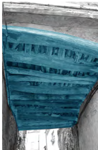
02 Forjado de vigas de madera con entrevigado cerrado por rollizos recibidos de mortero. Pasaje en Calle Cardona.
