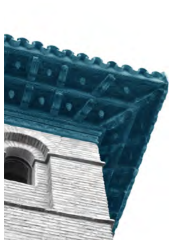
05 Alero de madera formado por dos niveles de ménsulas con tablero decorado con plafones en Plaza Aguilar
