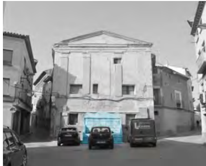
02 Fuente de las Canales
